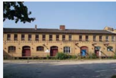
Ehemaliger Güterbahnhof Moabit
