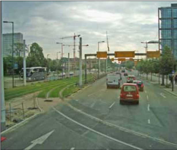
Die Bauarbeiten für die Straßenbahn in der Invalidenstraße gehen langsam voran. Während am Hauptbahnhof (im Bild rechts) schon der Rasen in den Gleisen verlegt wurde, sind im Bereich des „Platz vor dem Neuen Tor“ noch die Wasserbetriebe mit umfangreichen Tiefbauarbeiten beschäftigt.
