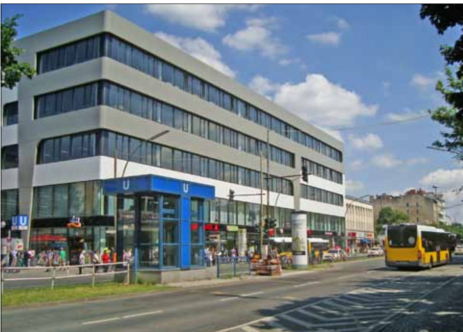
Turmstraße Blickrichtung Nordosten am U-Bahnhof Turmstraße. Der neue Aufzug auf dem Mittelstreifen spricht für den Standort der Straßenbahnhaltestelle hier anstatt in der Straße Alt-Moabit.
